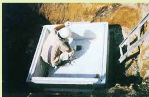
② 吊り金具をつけてBB部材(底つき)を4点吊りで据付レベル測定をして下さい。BB部材凹部のゴミ等をきれいに除去して下さい。
