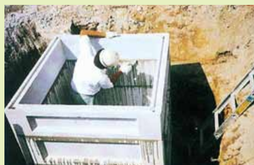
⑥ ハンドホール内部に付着したG-5除去作業 硬化したG-5は除去出来ませんので、施工後すぐ拭き取って下さい。
