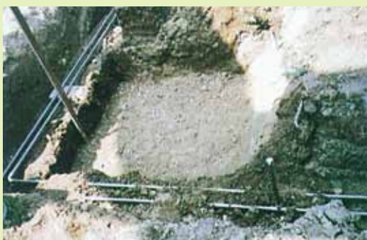
① 掘削、砂利地業
