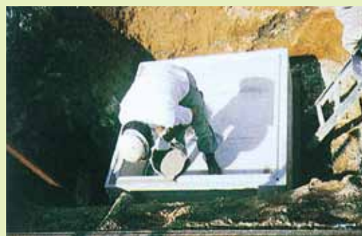
④ 防水材G-5をBB部材凹部に流しこんで下さい。
