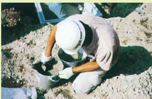
③ 防水材G-5を水とよく練り混ぜて下さい。
