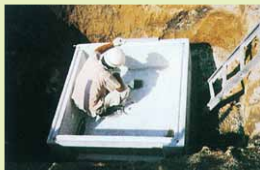
② 吊り金具をつけてBB部材(底つき)を4点吊りで据付レベル測定をして下さい。BB部材凹部のゴミ等をきれいに除去して下さい。
