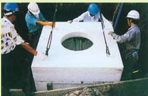
⑤ 最後にS,SBを施工して下さい。
