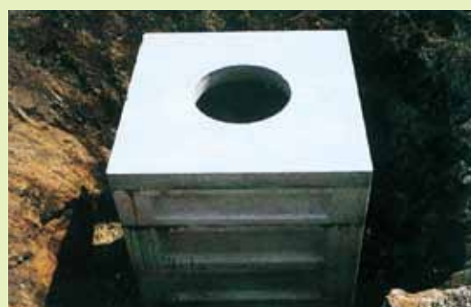
⑧ 組立状況
