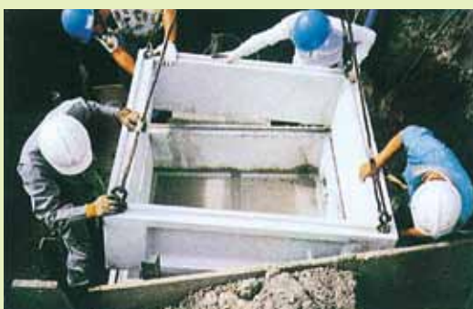
⑤ 次の部材を4点吊りで施工して下さい。
